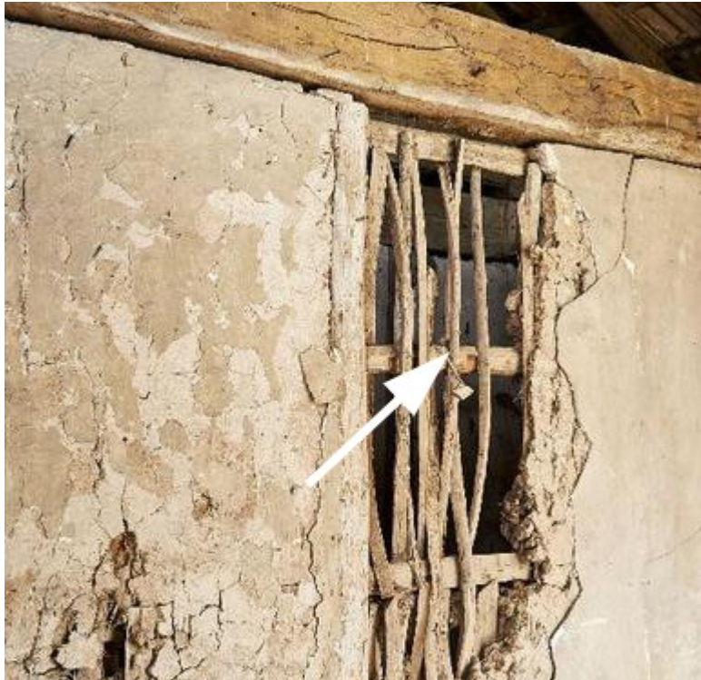
Illustration 24: Clayonnage composé de palaçons horizontaux en première trame et de baguettes verticales en 2e trame. (©Région Grand Est - Inventaire général/Ph.B.Drapier)
