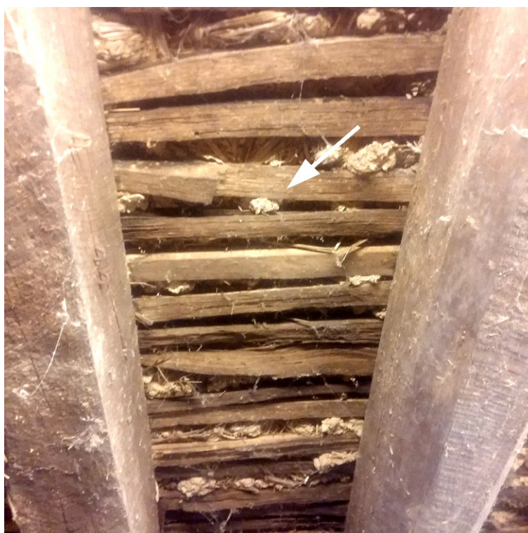
Illustration 18: un lattis au sol formant plancher non jointif et support de chape, vu par dessous (Mylène Gajic)
