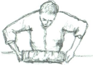
Illustration 30: Pose enroulée :Préfabrication d'andouilles, fuseaux, fusées ou quenouilles constitués de palançons ou barreaux enrobés de torchis sous forme de nappes ou de torches enroulées en spirales, souvent sur table.
