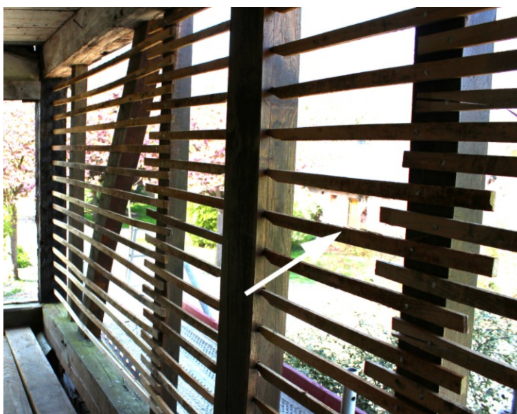
Illustration 16: Lattage formant lattis par endroit (Yan Minne)
