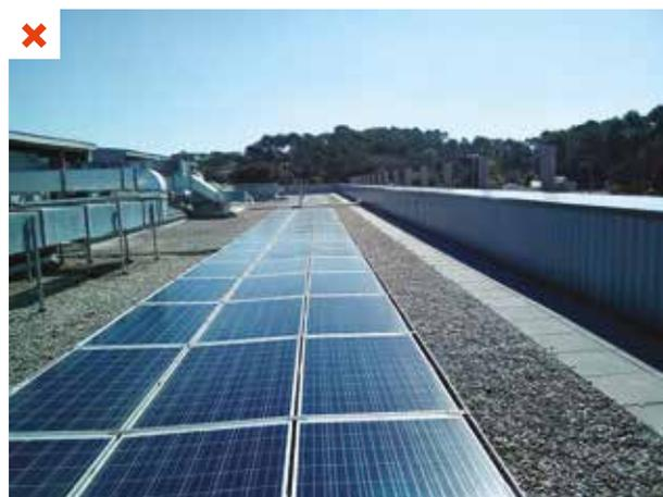
Par manque de place, les panneaux photovoltaïques sont installés à plat. Le rendement est diminué. ©AQC
