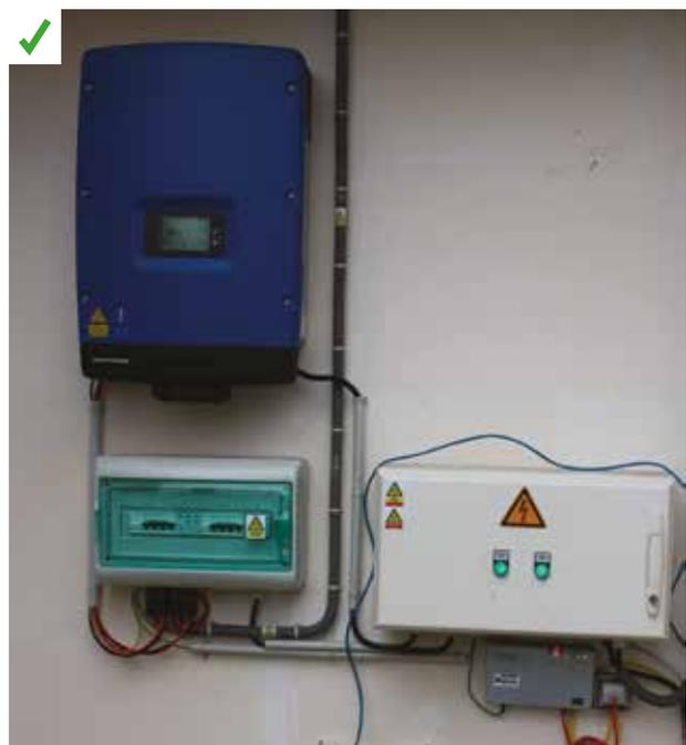
Un système d'alerte automatique a été mis en place via la GTB pour avertir le gestionnaire par sms lorsque les onduleurs disjonctent. ©AQC
