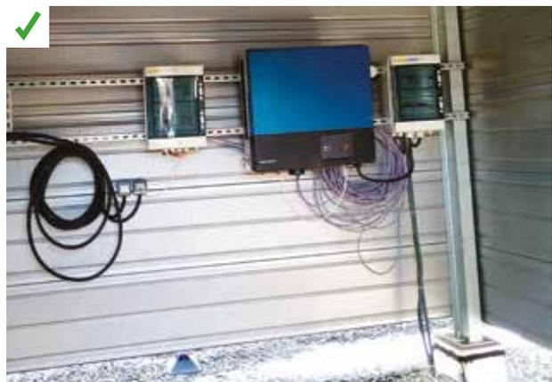
Situé en toiture, ce local est largement ventilé sur sa partie basse, avec un espace d'environ 30 cm sur tout le pourtour du local. Le brassage d'air maintient une température adéquate. ©AQC
