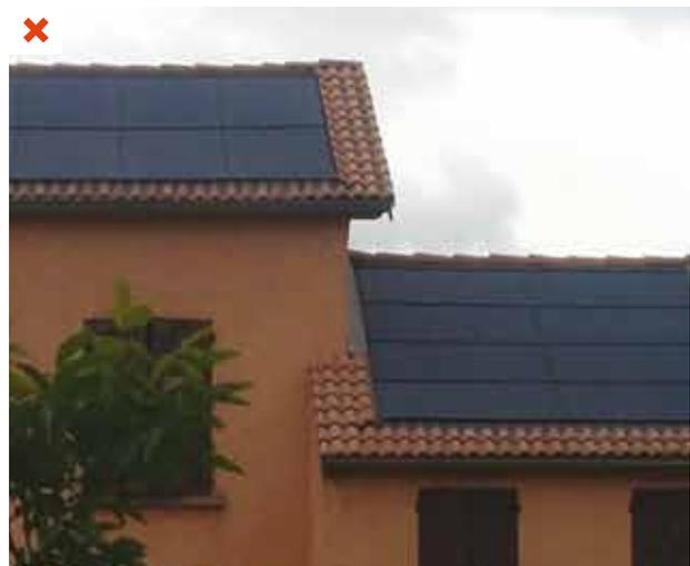
*La différence altimétrique des toits crée des ombres projetées l'après-midi sur une partie des panneaux. La baisse de rendement induite n'a pas été anticipée. ©AQC*
