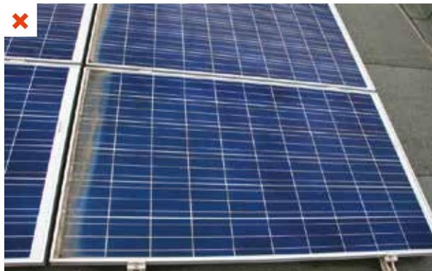
Saleté accumulée sur le dessus des panneaux dont l'inclinaison est quasi-nulle. ©AQC
