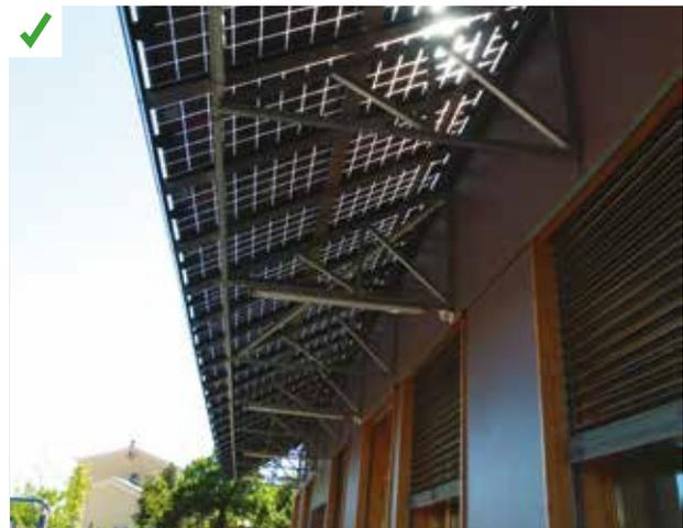
*Les panneaux ont une double fonction : production électrique et protection solaire des baies. Cette solution a été retenue en alternative au choix initial d'intégration en toiture. ©AQC*
