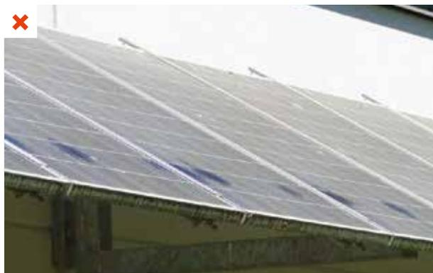
Des restes de fiente, ainsi que la poussière d'un chantier adjacent s'accumulent sur les panneaux. ©AQC
