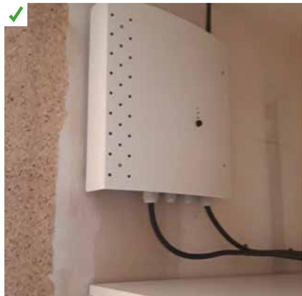
Un régulateur de thermoplongeur a été installé pour produire de l'eau chaude sanitaire avec le surplus de la production. ©AQC
