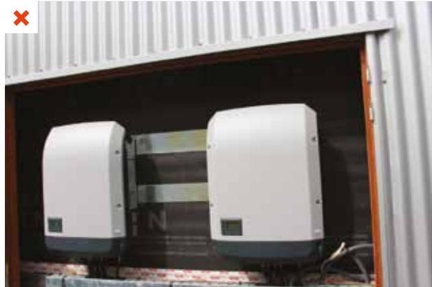
Une porte en tôle métallique, imitant le bardage en façade, ferme le local abritant les onduleurs. Celui-ci n'est pas ventilé et se réchauffe fortement avec le rayonnement direct du soleil sur la porte métallique. Cet apport de chaleur se cumule avec la chaleur produite par les onduleurs. ©AQC
