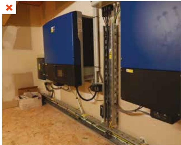
Ce local n'est pas ventilé. Il y a donc une surchauffe importante à l'intérieur pouvant altérer le bon fonctionnement des onduleurs et augmenter le risque d'incendie. ©AQC
