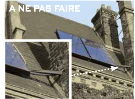
↑ Des mauvais exemples d'intégration des éléments techniques (panneau en surimpression et visibilité des tuyaux)
