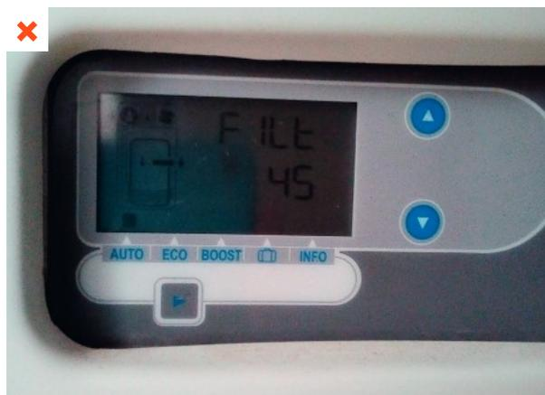
Le panneau d'affichage montre la saturation du filtre de la pompe à chaleur avec l'erreur « FILT ». Aucune intervention n'est prévue ni programmée. ©AQC
