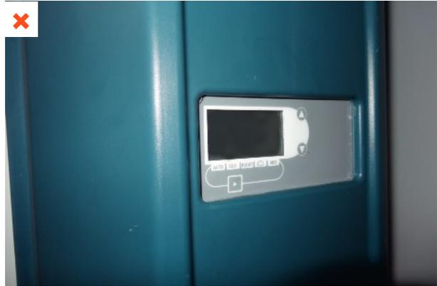
En période d'absence prolongée, l'alimentation électrique du CET sur air extrait est volontairement coupée. L'arrêt de la VMC peut générer une dégradation de la QAI et le développement de moisissures. ©AQC
