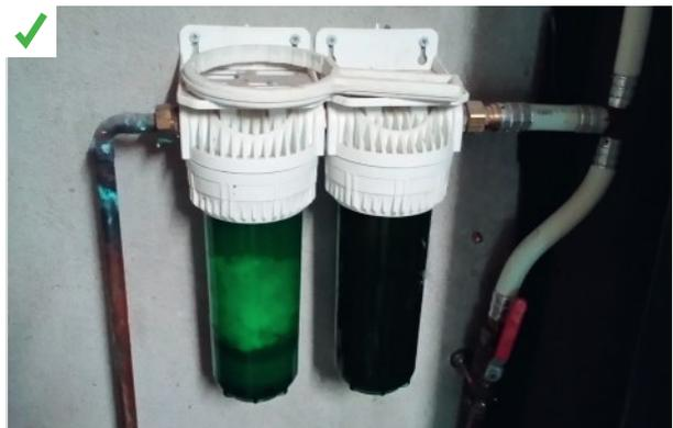
Mise en place d'un filtre à microparticules en amont du ballon d'eau chaude sanitaire.
