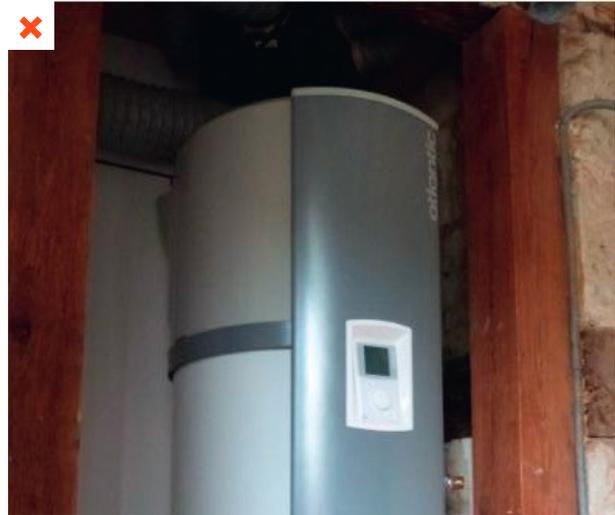
Le chauffe-eau est branché sur la VMC et est donc utilisé comme un CET sur air extrait, alors que le domaine d'emploi du produit ne le stipule pas. ©AQC
