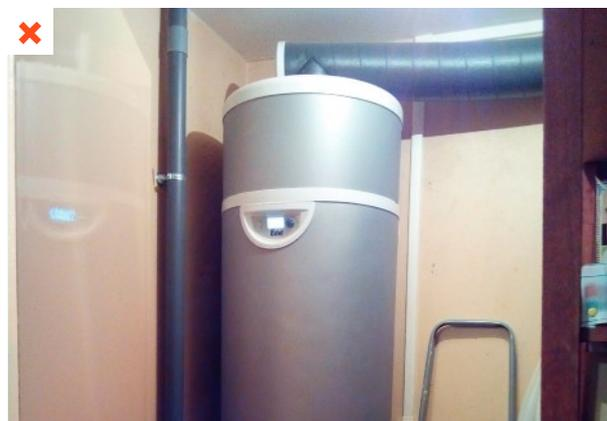
Le CET situé à proximité d'une chambre perturbe le sommeil des occupants. La cloison séparative et la traversée par la conduite aéraulique ne sont pas isolées acoustiquement. ©AQC
