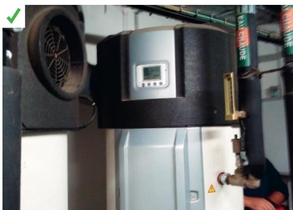
Pour répondre à une forte variabilité de l'occupation, deux CET sont installés en semi-parallèle. La fermeture de certaines vannes permet d'adapter le volume d'ECS disponible en fonction de l'occupation réelle. ©AQC
