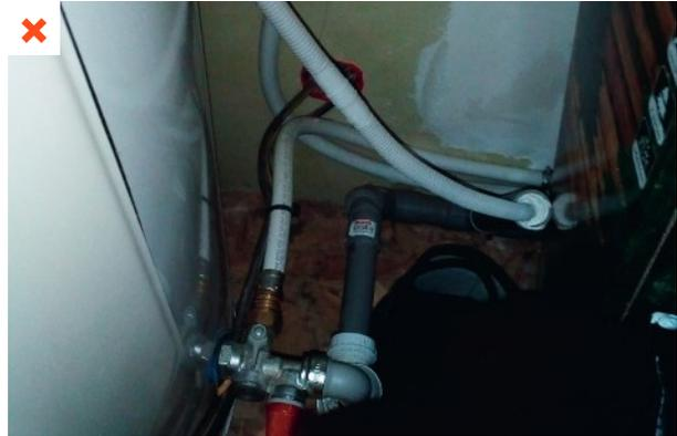
Dans ce local non chauffé, les canalisations d'eau chaude sanitaire ne sont pas isolées. La consommation d'eau chaude au point de puisage est plus importante pour obtenir la température souhaitée. ©AQC
