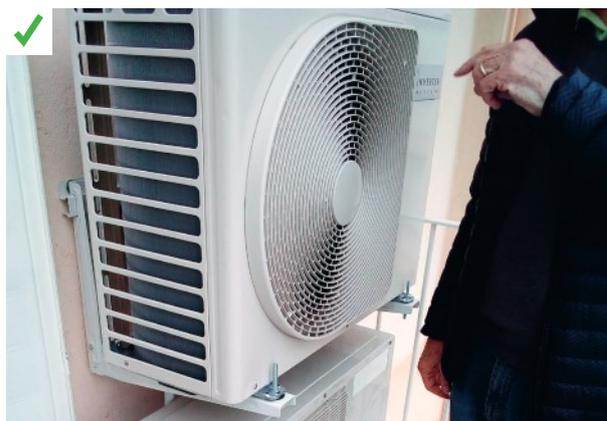
Le système à éléments séparés ou bibloc a été choisi pour éviter les nuisances sonores générées par le compresseur et le ventilateur. Ces deux éléments sont à l'extérieur. ©AQC
