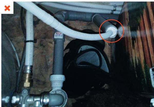
Le tuyau d'évacuation des condensats est relié au réseau d'évacuation, mais ne dispose pas de siphon. ©AQC
