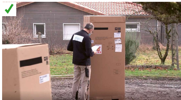
Les équipements et leurs caractéristiques techniques sont contrôlés lors de la réception sur le chantier avant l'installation. ©AQC
