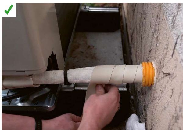
Un complément d'isolation avec un matériau adapté est appliqué sur les parties initialement non calorifugées. ©AQC
