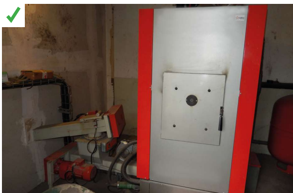
Vis sans fin d'alimentation directe entre le silo de stockage et le foyer avec un angle inférieur à 15°. ©AQC
