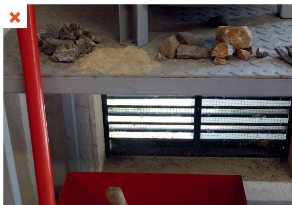
Pierres trouvées dans la vis sans fin d'alimentation en combustible du foyer. ©AQC
