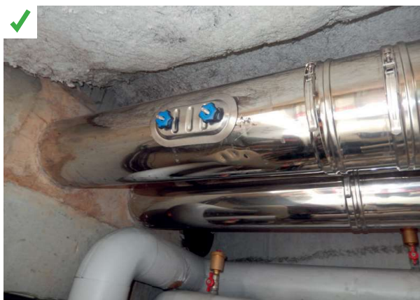
Une trappe d'accès pour faciliter le ramonage a été installée a posteriori. Une attention particulière doit être portée sur la compatibilité et le domaine d'emploi de cette trappe. ©AQC
