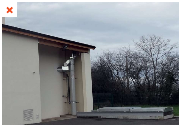
Le système de convoyage entre la trémie de livraison et le lieu de stockage est composé de 3 vis sans fin, une première horizontale, une deuxième verticale et une dernière horizontale. Le risque de bourrages et de casses est augmenté. ©AQC
