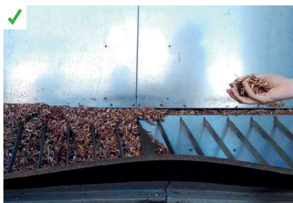
Contrôle visuel des plaquettes au moment de la livraison. Les barreaux métalliques sur le silo de dépotage facilitent le contrôle visuel. ©AQC
