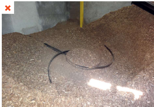
En fin de saison, le silo n'a pas été vidé et la maintenance du silo et du dessileur est rendue difficile. ©AQC
