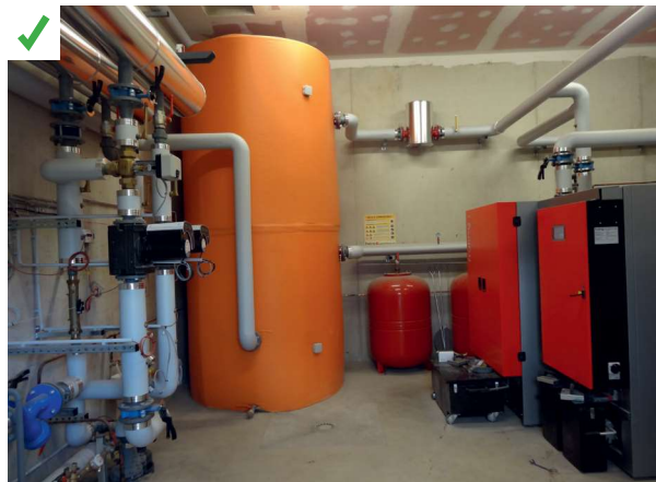
Pour limiter les courts cycles et les temps de fonctionnement en deçà de la puissance nominale, un ballon tampon a été installé.
