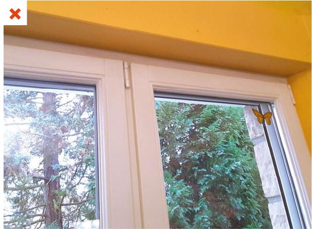
Sur cette menuiserie d'un séjour, il n'y a pas d'entrée d'air. Dans ce cas de rénovation légère, un système d'extraction a été installé dans les pièces humides, mais les menuiseries extérieures n'ont pas été remplacées. ©AQC
