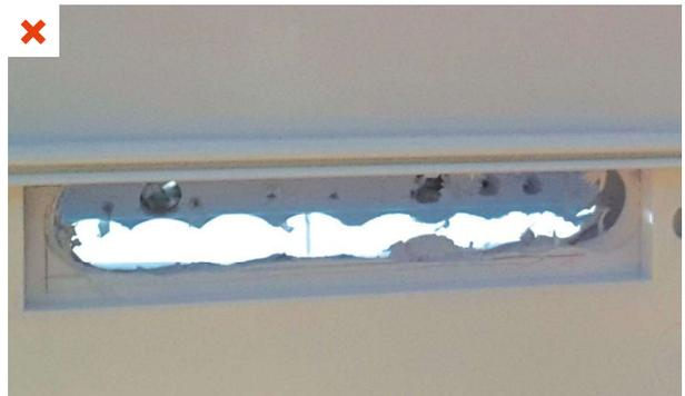
Lors de l'installation d'un système d'extraction, des entrées d'air dans les menuiseries existantes ont été créées. La mortaise a été réalisée manuellement à l'aide d'une perceuse. Outre la mauvaise réalisation et le risque de dégradation de la fenêtre, la section de passage de l'air est insuffisante. ©AQC
