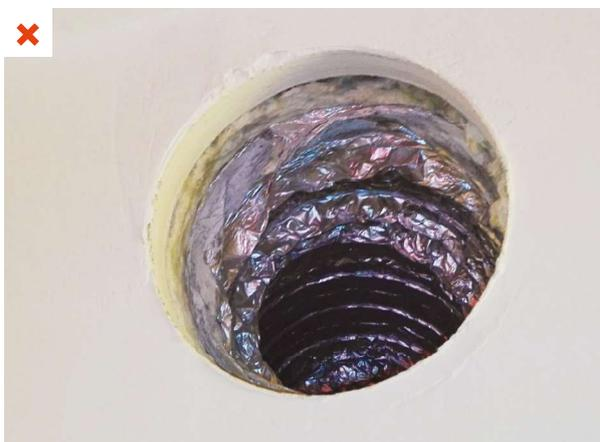
Lorsque la bouche d'extraction est retirée pour son entretien, la manchette de raccordement se retire également. Aucun raccordement mécanique ni aucune étanchéité à l'air n'ont été réalisés entre la manchette et la gaine d'extraction. ©AQC
