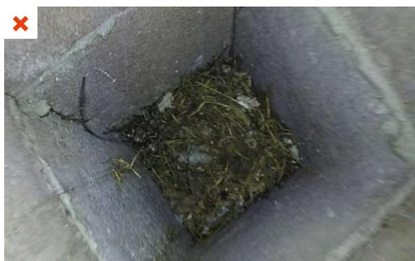
Le conduit existant est obturé par des feuillages (nid d'oiseau), ce qui ne permet pas l'extraction de l'air vicié des logements raccordés en dessous de l'obturation. @Air efficience
