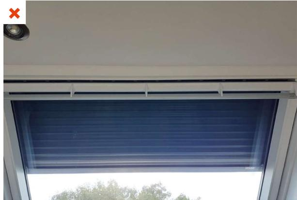
L'ouverture du clapet de ventilation est considéré à tort comme une entrée d'air. Le débit d'air entrant n'est pas maîtrisé et l'arrivée d'air n'est pas pérenne puisque le clapet peut être refermé manuellement. ©AQC
