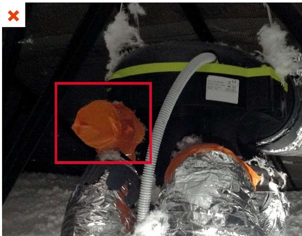
Le piquage non utilisé sur le caisson a été obturé avec de l'adhésif de chantier au lieu d'un bouchon adapté. ©AQC
