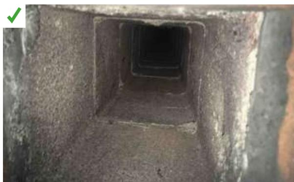
L'objet obturant partiellement le conduit, identifié et localisé lors de l'inspection vidéo, a été retiré. @Air efficience
