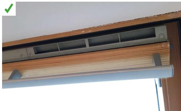
Sur cette fenêtre de toit, un module d'entrée d'air spécifique est installé en remplacement du clapet de ventilation. L'arrivée d'air est permanente et dimensionnée en fonction de la destination de la pièce. ©AQC
