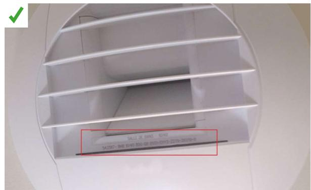
La bouche d'extraction comporte l'inscription de sa référence. Ceci a permis de vérifier qu'elle est adaptée au logement et compatible avec le système de ventilation mis en œuvre. ©AQC
