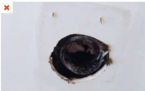
La manchette de raccordement n'a pas été mise en œuvre. Le terminal du réseau aéraulique n'étant pas fixé au parement, la bouche d'extraction ne peut pas être raccordée de façon étanche à l'air. ©AQC
