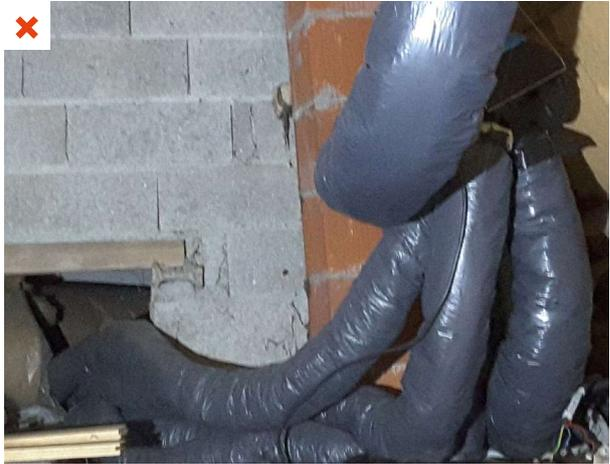
Les réseaux souples raccordés au caisson présentent tous un point bas, favorisant l'accumulation d'eau en cas de condensation. L'installation a été réalisée, dans ce cas, en un temps très court. ©AQC
