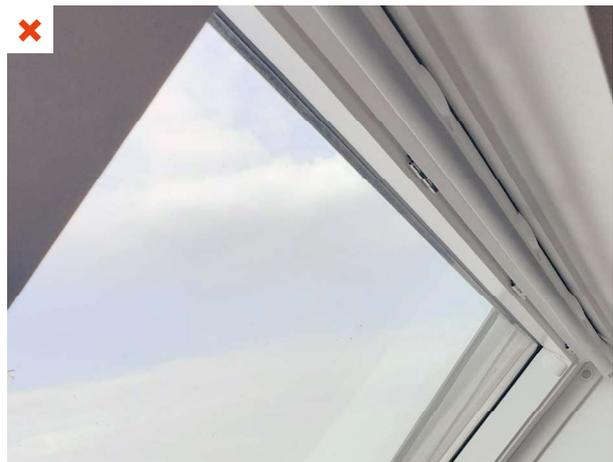
Sur cette fenêtre de toit installée dans une chambre, il n'y a pas de module d'entrée d'air spécifique « fenêtre de toit ». De plus, le clapet de ventilation est en position fermée ne permettant pas, a minima, d'assurer une aération temporaire et volontaire. ©AQC
