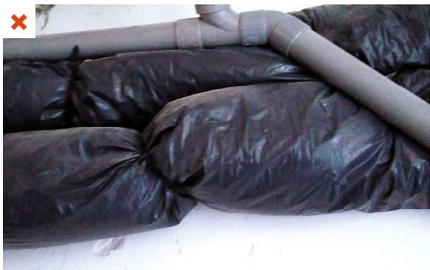
Les colliers installés pour maintenir la gaine souple contre le mur sont trop serrés et réduisent le diamètre de passage de l'air. ©AQC
