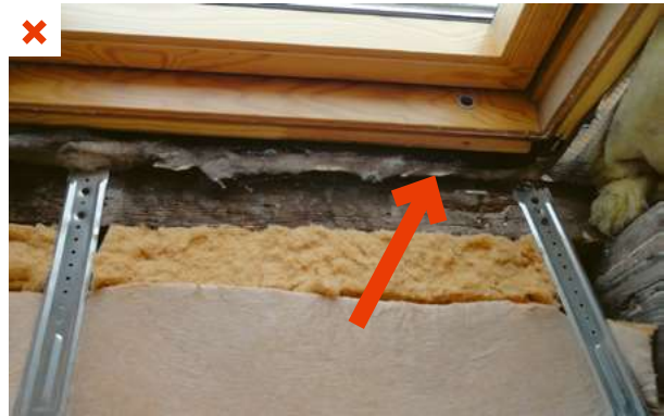
Les panneaux en fibre de bois sont appliqués en sous-face d'un produit mince réfléchissant non microperforé (flèche orange). N.B.: Il existe outre un problème de continuité de l'étanchéité à l'air avec le dormant ©AQC
