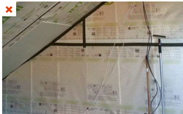
La membrane d'étanchéité à l'air est collée sur les fourrures métalliques à l'aide d'un adhésif double face. La plaque de plâtre, vissée également sur les fourrures métalliques, se retrouve en contact direct avec la membrane. ©AQC
