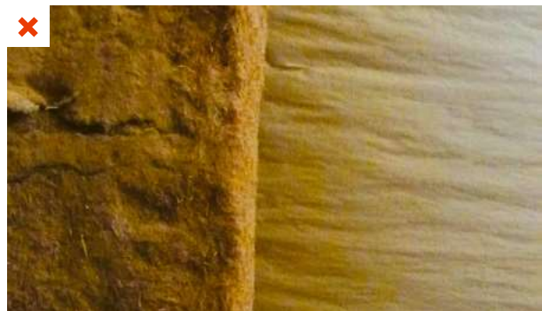
Les panneaux en fibre de bois sont appliqués en sous-face d'un pare-vapeur déjà en place. ©S.Courgey
