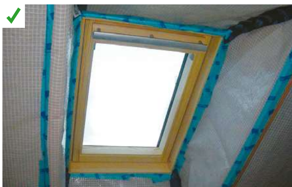
L'interface entre la fenêtre de toit et les rampants est isolée et étanche à l'air. ©AQC
