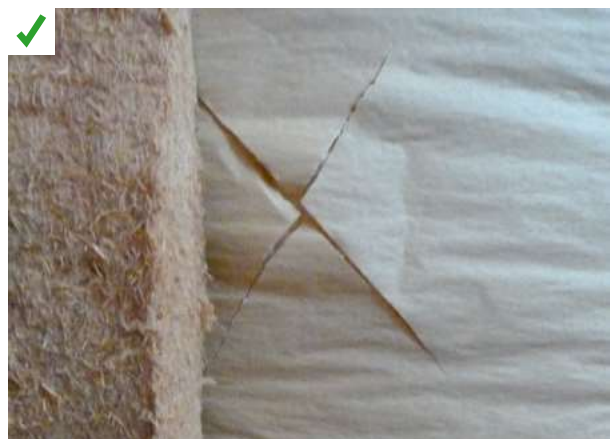
En cours de chantier, des fentes ont été réalisées de façon régulière sur le pare-vapeur existant avant la mise en place des panneaux isolants. ©S.Courgey
