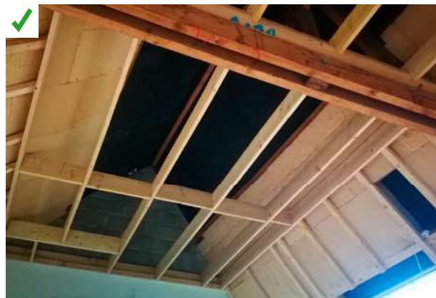
Grâce à des découpes précises et soignées, les panneaux de fibre de bois sont positionnés entre chevrons sans laisser d'espaces vides. La densité des panneaux participe également à leur bonne tenue. Une seconde épaisseur d'isolant en couche croisée sera mise en œuvre avant la pose de l'étanchéité à l'air.
