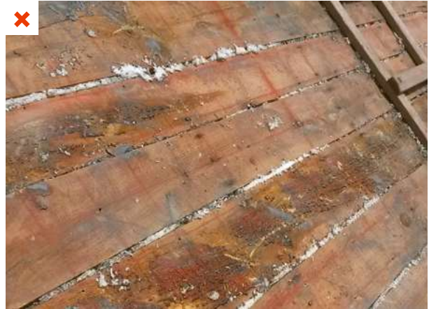
Absence de lame d'air. L'isolant est au contact du voligeage. ©AQC
