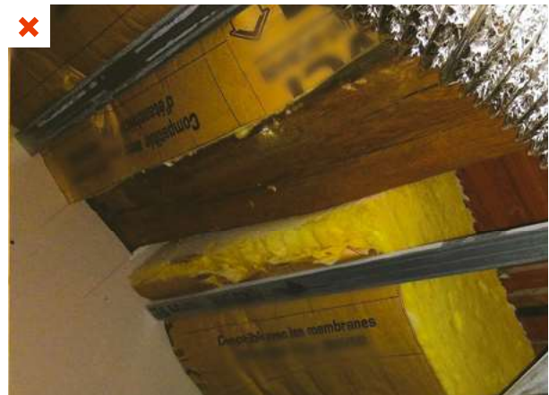
L'isolant est plaqué contre les liteaux. Aucune lame d'air n'est présente en sous-face de la couverture en tuiles. ©AQC
