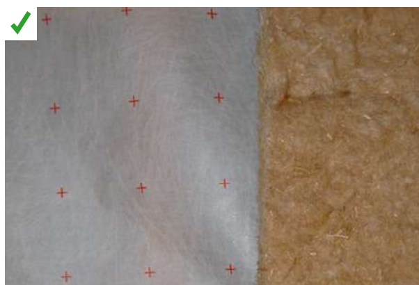
Pose de la membrane pare-vapeur et d'étanchéité entre deux couches d'isolant selon la règle dite des 2/3-1/3. (1) ©S.Courgey
