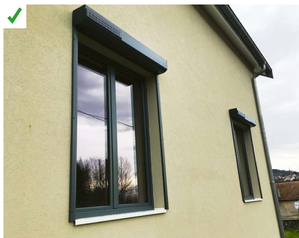
Les volets roulants sont fixés au nu extérieur de l'ITE avec des accessoires adaptés. Le pont thermique est ainsi évité. ©AQC
