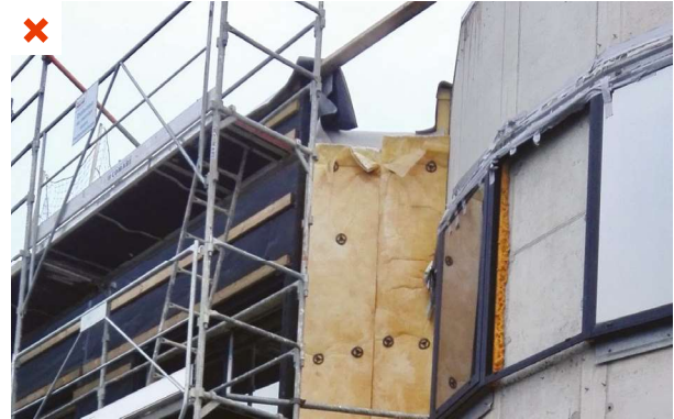
Les panneaux de laine minérale sont soumis à la pluie et au vent. Les panneaux en haut de façade se dégradent fortement.
