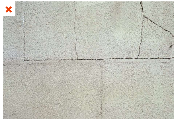
Le support de l'ITE présente des lézardes traversantes. La tenue mécanique de l'isolant par chevilles ne peut être assurée. ©AQC
