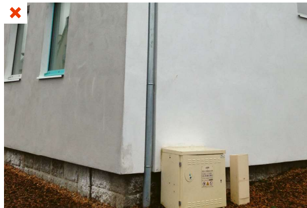
La descente d'eau pluviale n'a pas été déposée avant les travaux d'isolation, ce qui génère un important pont thermique linéaire.
