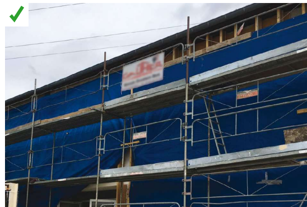
Protection de la façade et de l'isolant avec une bâche contre les intempéries. ©AQC
