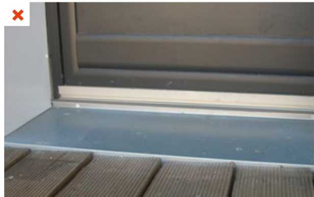
Pose d'un seuil « à la suisse » avec calfeutrement garantissant l'étanchéité à l'air et à l'eau mais non adapté aux PMR. ©AQC
