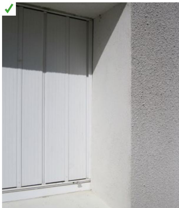
Bonne pratique : le retour d'isolant en tableau de fenêtre a bien été pris en compte et permet de limiter le pont thermique à l'interface. ©AQC
