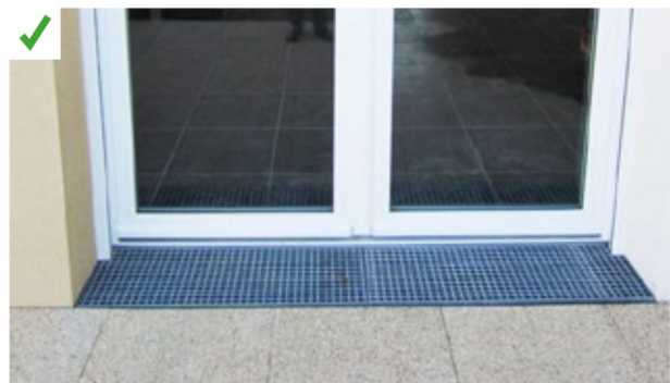
Exemple de solution avec le système de dalle sur plot en extérieur – Source : Cahier du CSTB Carnets de détails pour l'accessibilité des balcons, des loggias et des terrasses dans les constructions neuves. ©AQC
