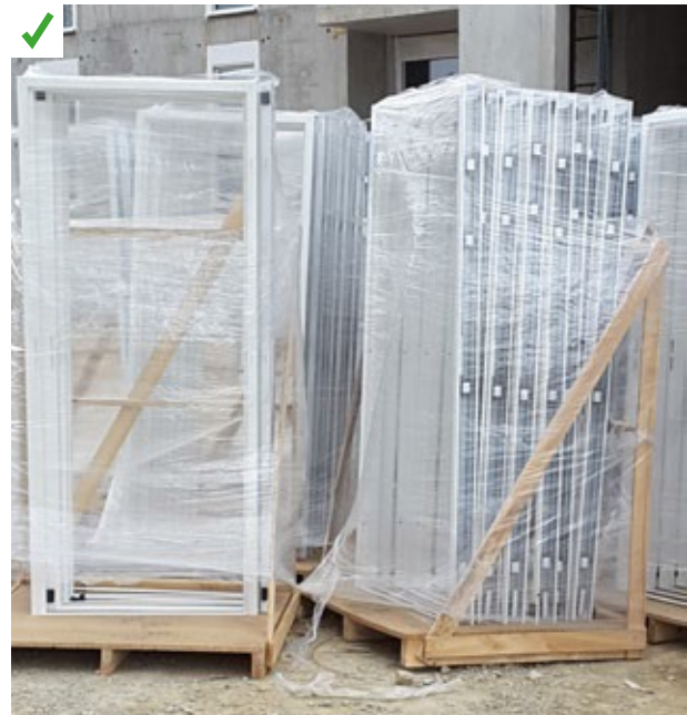
Bonne pratique de stockage sur chant par lot de 10 menuiseries. ©AQC
