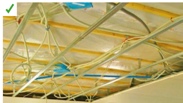
Les spots encastrés sont déplacés dans le plénum technique réalisé sous la membrane d'étanchéité à l'air sous le plancher nouvellement isolé. La hauteur de ce type d'espace doit être supérieure à 10 centimètres pour pouvoir dissiper la chaleur produite par les éclairages. ©AQC
