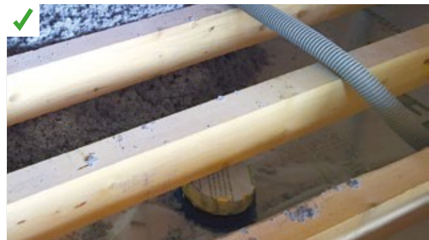
Un capot de protection adapté recouvre le spot encastré. Le traitement de l'étanchéité à l'air englobe le dispositif. ©AQC
