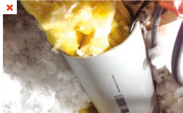
Des tubes en PVC remplis de laine de verre font office de protection des spots encastrés. ©AQC
