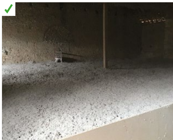
Délimitation de la zone isolée à l'aide d'une plaque verticale pour contenir l'isolant. ©AQC
