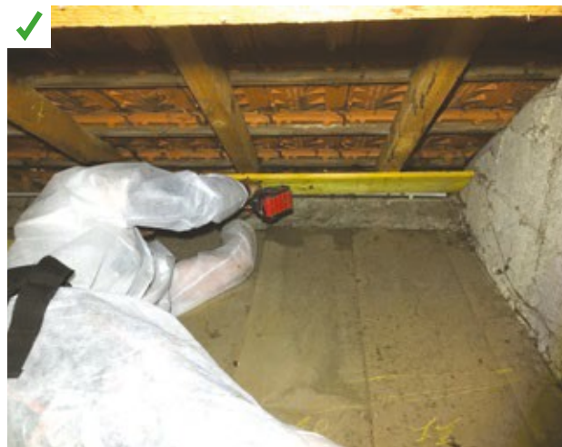
Mise en place de déflecteurs en bas de toiture pour maintenir la continuité de la lame d'air ventilée sous les tuiles. ©AQC
