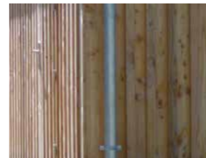
POSE À COUVRE-JOINTS Essence : Douglas
