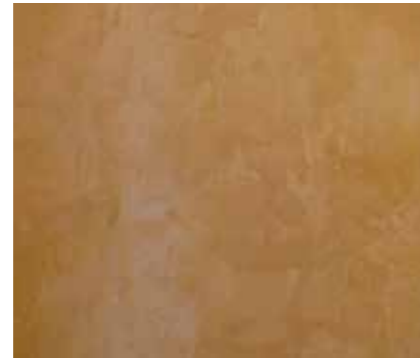
L'ARGILE OU ENDUIT TERRE , crée un climat intérieur optimal par la régulation de l'humidité atmosphérique en absorbant la vapeur d'eau et en la recédant lentement lorsque l'air est trop sec. Il capte les mauvaises odeurs.
