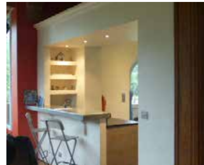
L'ENDUIT PLÂTRE , réalisé en trois couches, il peut être recouvert d'un badigeon au lait de chaux.
