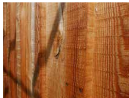
POSE À COUVRE JOINTS Essence : Mélèze
