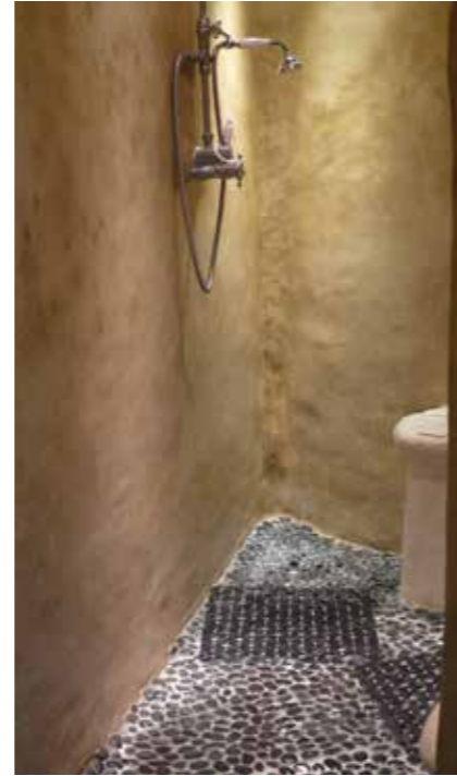
L'ENDUIT TADELAKT est un enduit terre saturé à la chaux. Le ferrage de cet enduit permet de le rendre imperméable pour les pièces d'eau.
