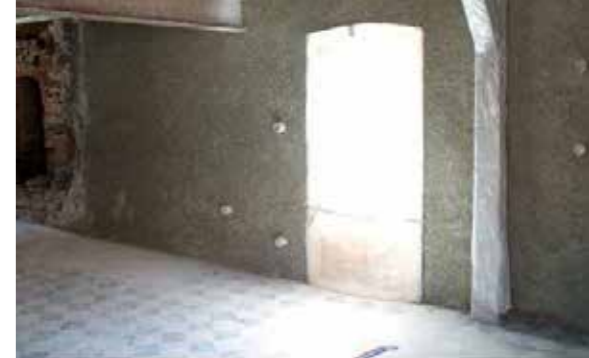
Isolation en mortier chaux chanvre
