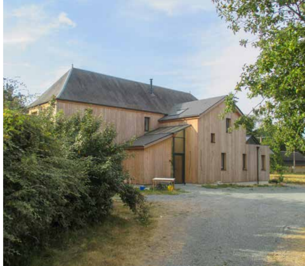
ATELIER D'ARCHITECTURE PASCAL SÉJOURNÉ, ARCHITECTE (27) L'extension en bardage bois de type Douglas ne nécessite ni traitement ni entretien. Il recouvre ici une isolation en laine de bois.
