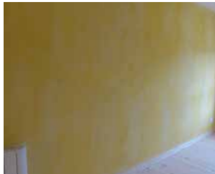
LE LAIT DE CHAUX est utilisé en finition pour donner un aspect lisse ou coloré au mur.
