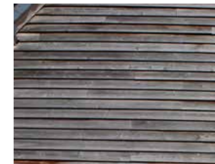
BARDAGE TRADITIONNEL pose horizontale. Recouvrement en Mélèze
