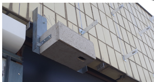
Intégration de nichours à martinets noirs sur le site pilote APHP Saint-Antoine - Paris. © LPO IDF
