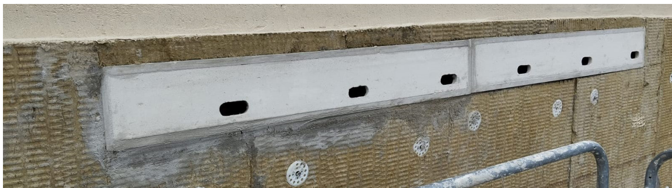
Intégration de nichoirs triples à martinets sur le site pilote d'Orly © Elsa Caudron
